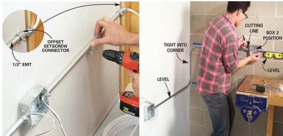
Fig. 4.1.22: Procedure for Open Conduit Wiring
